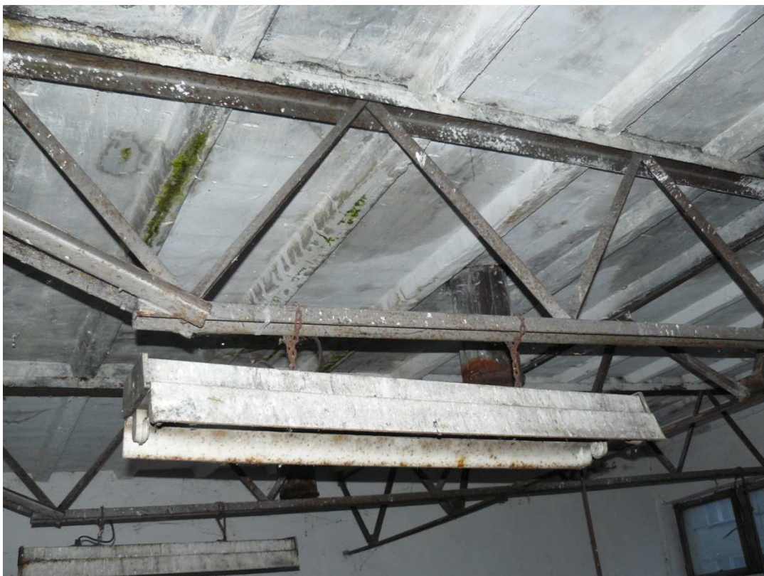
Zdjęcie 5 Kratownice dachowe części wyższej opartych bezpośrednio na ścianach podłużnych.
