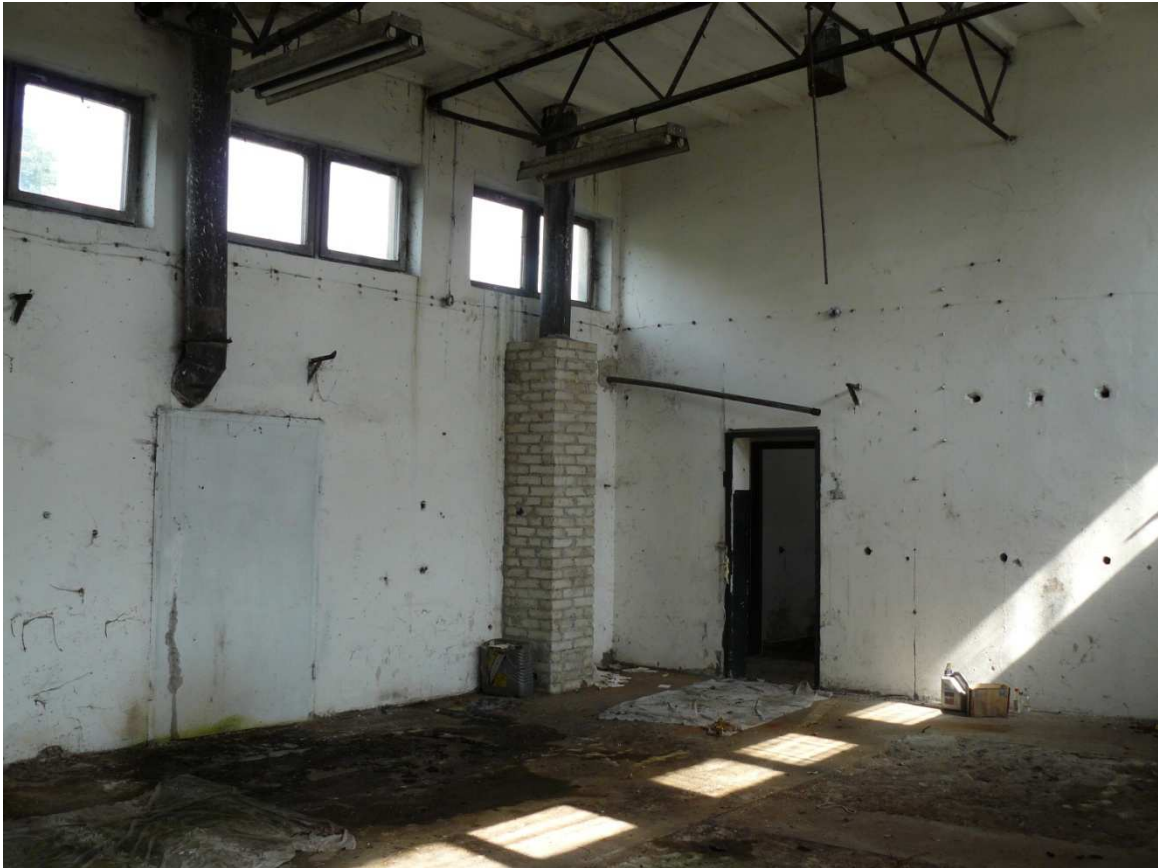
Zdjęcie 6 Ściany wewnętrzna gr. 25 i zewnętrzna gr. 38 cm w pomieszczeniu kotłowni Zmiana sposobu użytkowania nie spowoduje zwiększenia obciążeń i przekroczenia nośności istniejących ścian.
