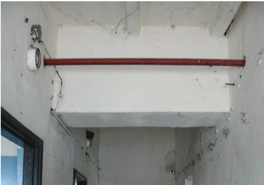
Zdjęcie 7 Podciąg pod ścianą zewnętrzną w korytarzu
